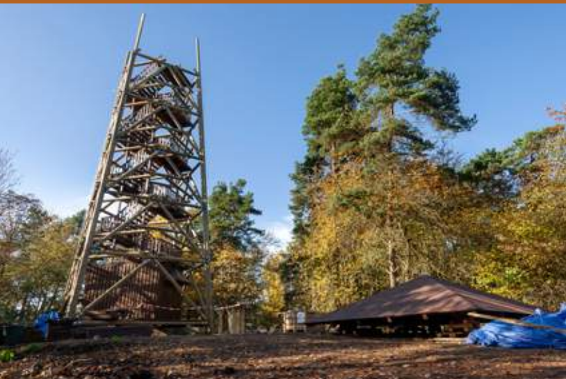
↑ Výstavba rozhledny na Besedné, stav z 2. listopadu 2014
